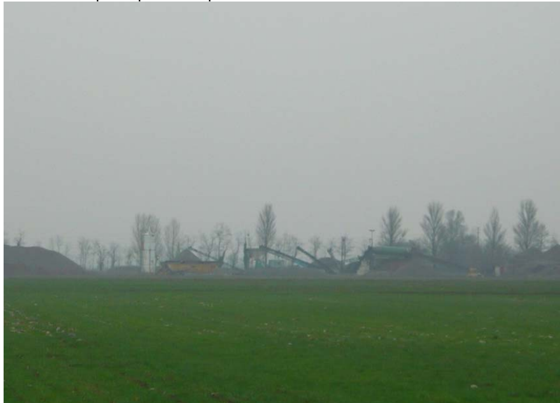
FOTO 3: Comparto p16-A: impianto di lavorazione inerti in località Il Follo
